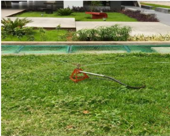
SPRINKLER SYTEM- REUSE WATER
